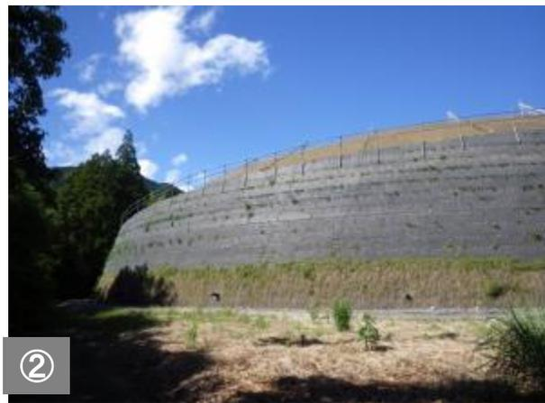
② 補強土壁、前面の様子です。補強土壁は完成し、上部に路体盛土の様子が見ることができます。
