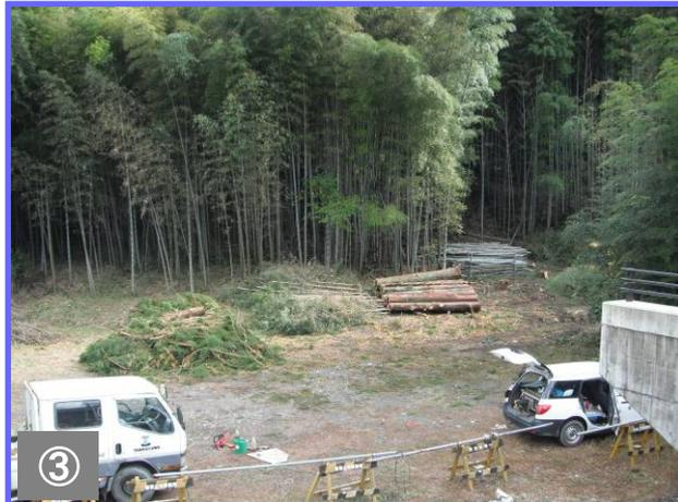
橋の左岸側の工事に着手しました。青部バイパスと県道川根寸又峡線を接続する取合道路の工事です。現在は、工事箇所の立木を伐採しています。
