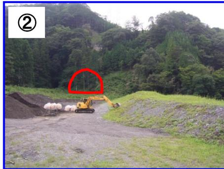
トンネル終点側（青部駅側）坑口部の状況です。立木の伐採が終わり、今年度末から掘削予定のトンネル工事用の施工ヤードを整備しています。
