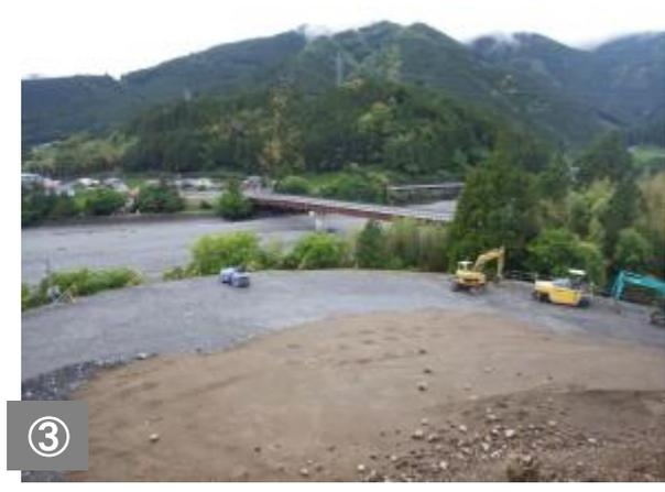
③ 取合道路の路体盛土をしております。盛土工事後、水路やガードレールの設置、アスファルト舗装を実施します。
