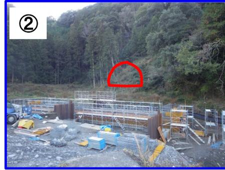
トンネル終点側（青部駅側）坑口部の状況です。坑口部手前で普通河川の暗渠化を図っています。
